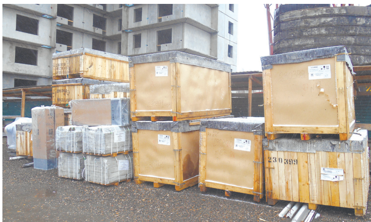
Новые лифты уже привезены в Добрянку и ждут своего часа.
